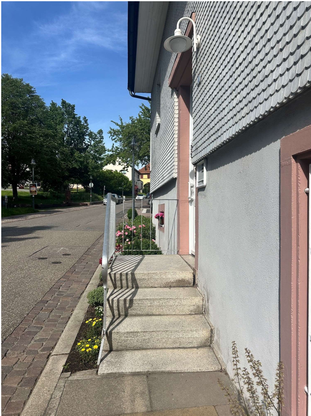
Foto 5 – Hauseingang unmittelbar an der Fahrbahn
